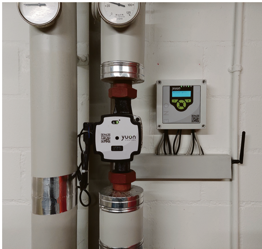
Minimale Intervention, maximale Optimierung: Der Heizungsregler «Yuon One» stimmt die Heizleistung auf die individuelle Beschaffenheit des Hauses ab. zvg
